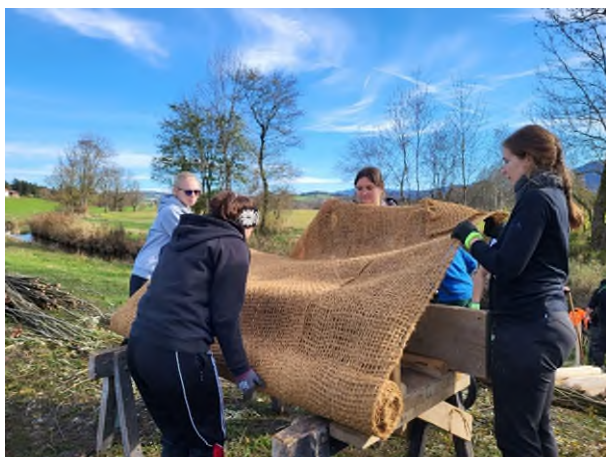
Abbildung 1: Studentinnen der FH Weihenstephan-Triesdorf bereiten eine Kokosmatte vor, in die die Weidenzweige eingewickelt werden. Foto: Wasserwirtschaftsamt Traunstein
