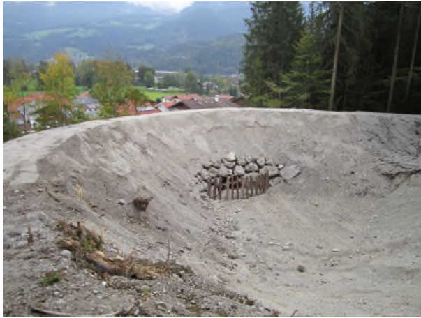
Abbildung 1: Ein großes im Zuge der Vorwegmaßnahmen erstelltes Auffangbecken samt Wildholzrechen schützt die Bewohner der Waldhausersiedlung in Schönau am Königssee. Bei einem Murenabgang fangen Becken und Rechen die Geschiebmassen auf.
