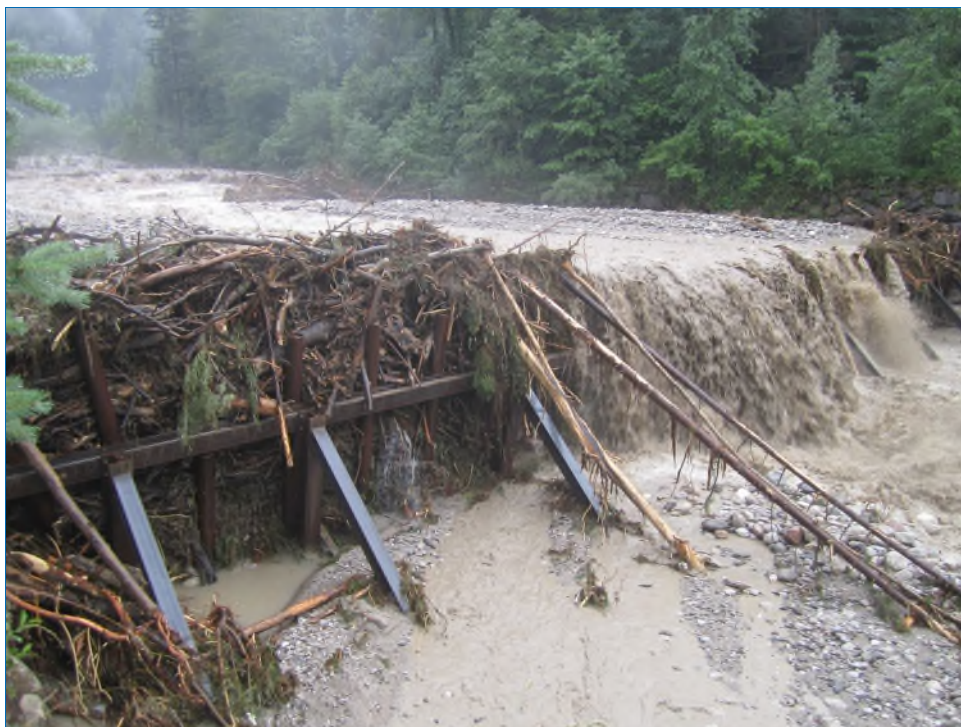
Abbildung 3: Wie stark die Belastung der Wildholzrechen war, zeigt das Beispiel am Larosbach in Berchtesgaden. Unmengen an Geschiebe und Wildholz hatten sich aufgestaut und den Rechen verstopft. Mittlerweile sind Geröll, Schlamm und Totholz abtransportiert.
