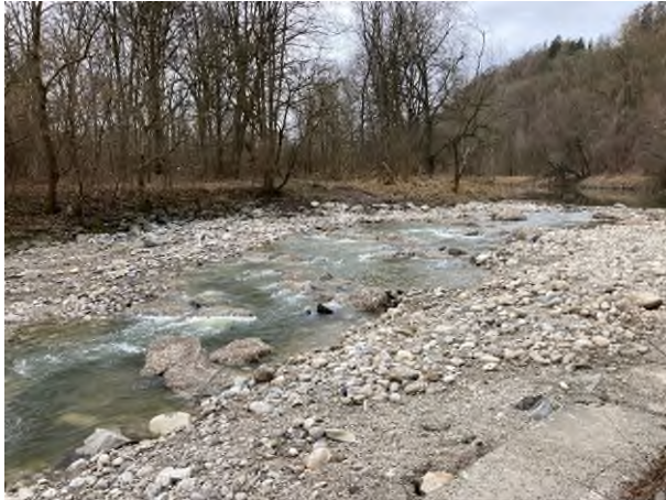
Abb. 3: Isen bei Steinhöring nachher: Die Steinriegel sind so angelegt, dass die Fische wie in einem natürlichen Bachlauf flussaufwärts schwimmen können. Foto: Wasserwirtschaftsamt Traunstein
