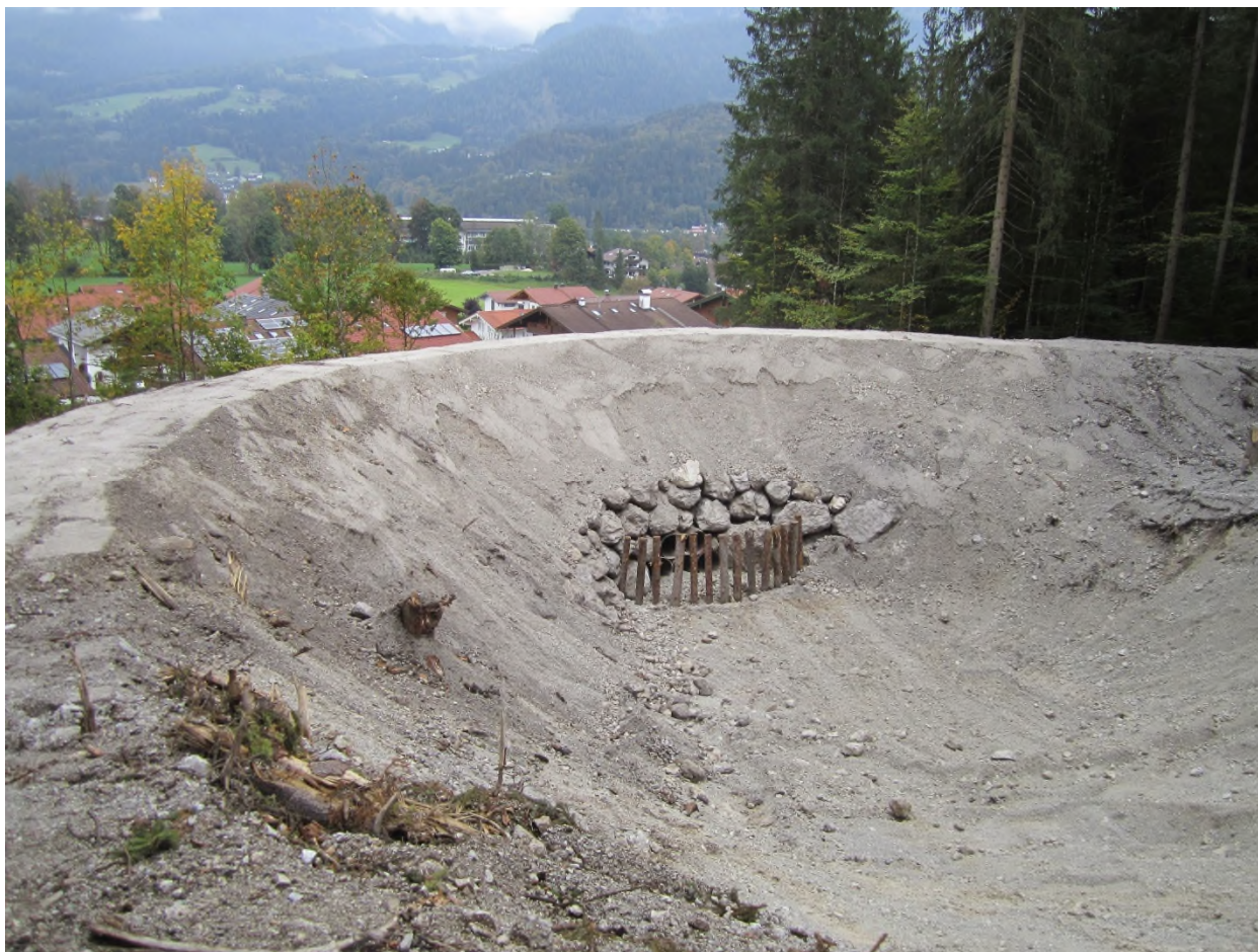
Das neu gestaltete Auffangbecken am Nordhang des Grünsteins in Schönau am Königssee fasst ein Volumen von rund 3000 Kubikmeter. Holzpfähle dienen als Wildrechen, die Rohre leiten Wasser gezielt ab.
