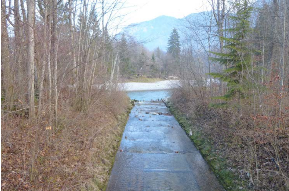
Abb. 1: Alter Zustand - Nicht durchgängiger Mündungsbereich des Wössener Bachs
