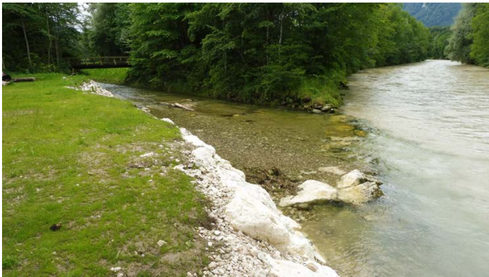
Abb. 2: Neuer Zustand - Aufgeweiteter und umgestalteter Mündungsbereich des Wössener Bachs in die Tiroler Achen
