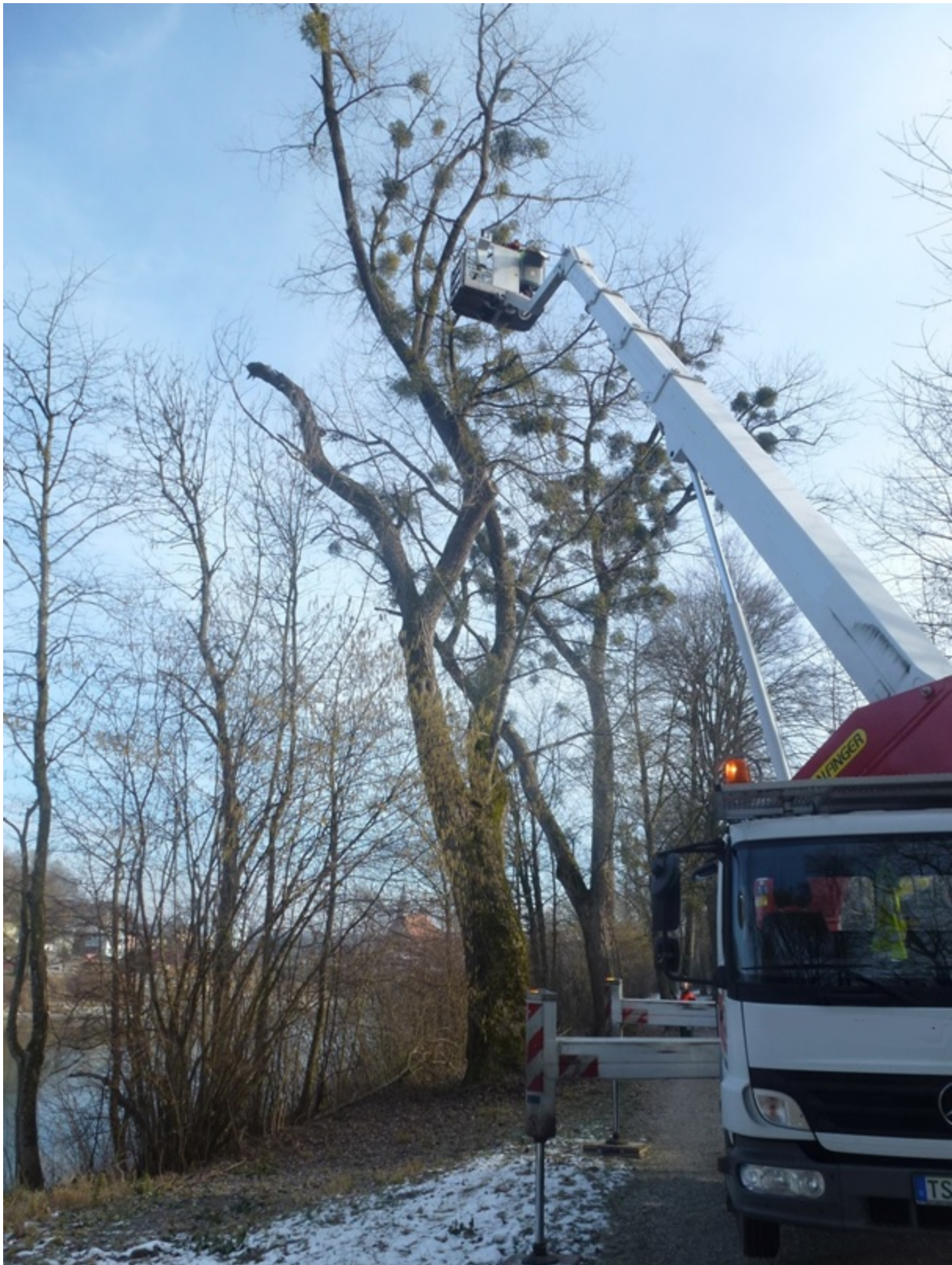
Schwere Hebebühne zur Baumpflege an Großbäumen am Salzachuferweg
