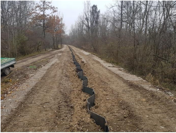
Im Deich eingebaute Spundwand
