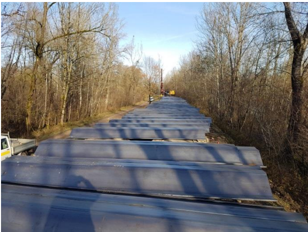
Spundwandlager auf der Deichkrone
