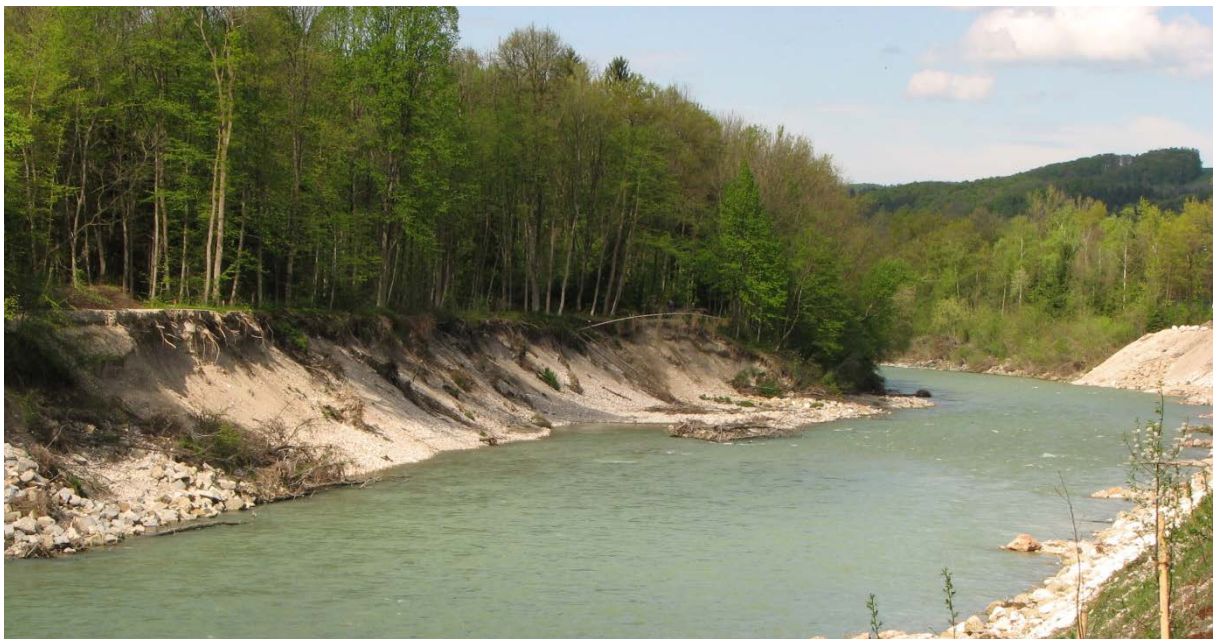
Uferabbrüche im Unterlauf der Saalach, entstanden beim Jahrhunderthochwasser 2013 (Foto: Wasserwirtschaftsamt Traunstein)
