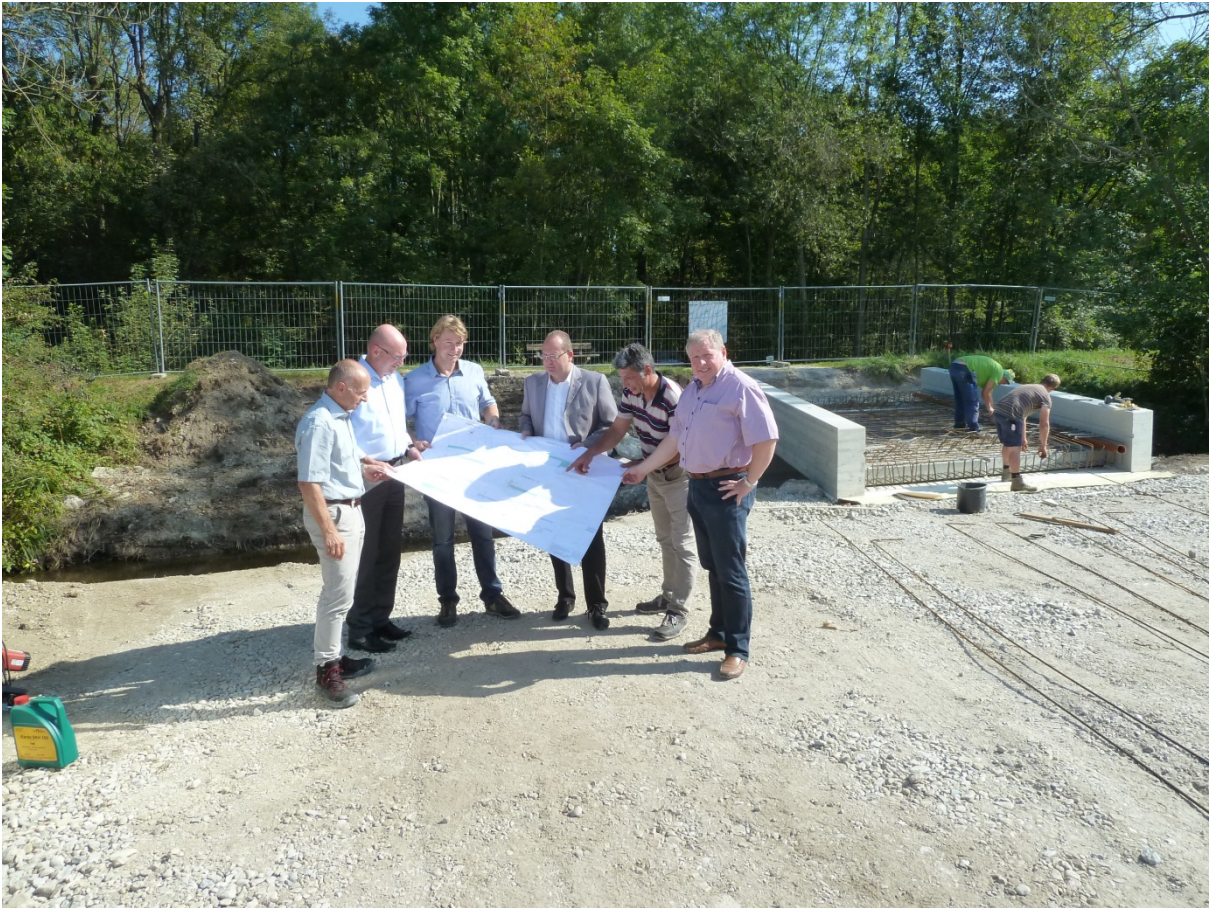
Baustellenbesichtigung (von links) Walter Raith WWA Traunstein, Bgm. Bernhard Kern Gde. Saaldorf-Surheim, Tobias Nöhrig Bauleitung S.A.K – Ingenieurbüro, Bgm. Hans Feil Stadt Laufen; Huber Baufirma Plereiter, Hans Althammer S.A.K-Ingenieurbüro.
